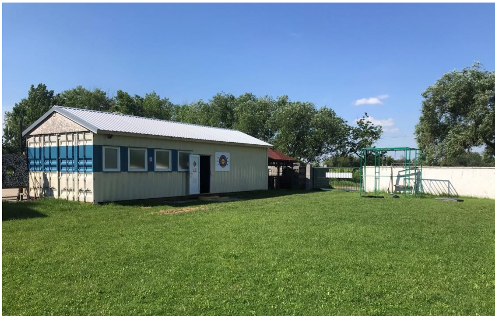
Obr.4 Zrekonštruovaný lodný kontajner na klubové priestory a krytú strelnicu
